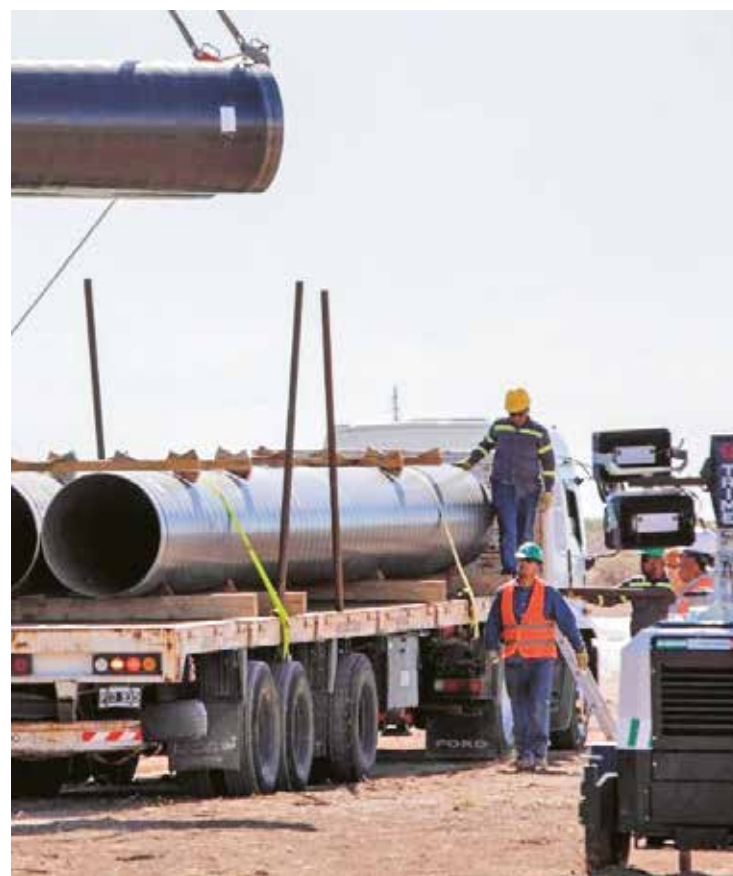
El segundo tramo del Gasoducto de Vaca Muerta tiene financiamiento privado.
