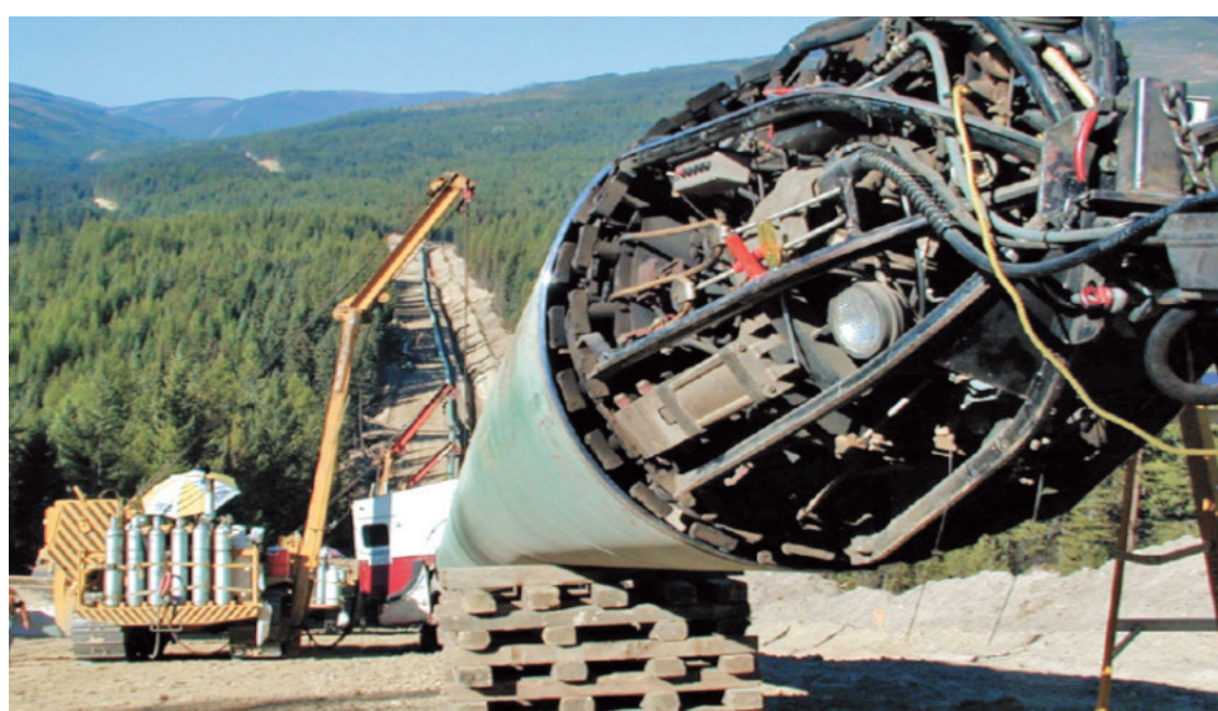
Se utilizó por primera vez en el país una soldadora automática que redujo los tiempos y mejoró la eficiencia.
